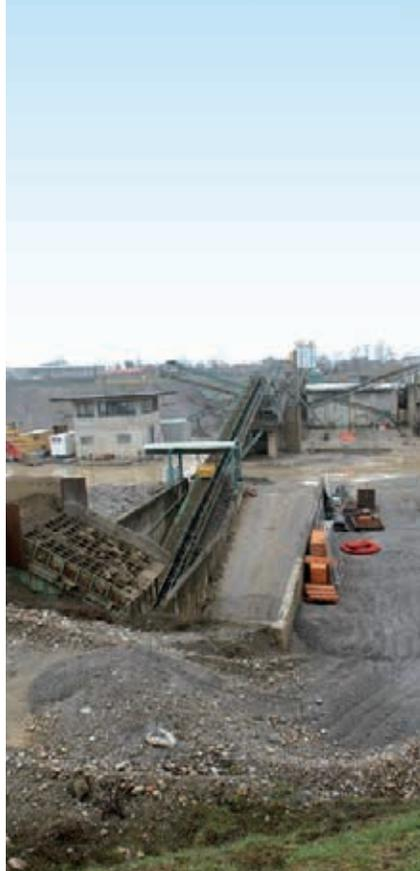
pendii. Tutta l'area produttiva è cementata e dotata di un sistema per il recupero dell'acqua, il suo trattamento e il riutilizzo nel ciclo produttivo.
